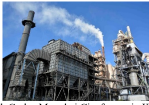
Das Zementwerk Carlos Marx bei Cienfuegos in Kuba. Foto: ACN
